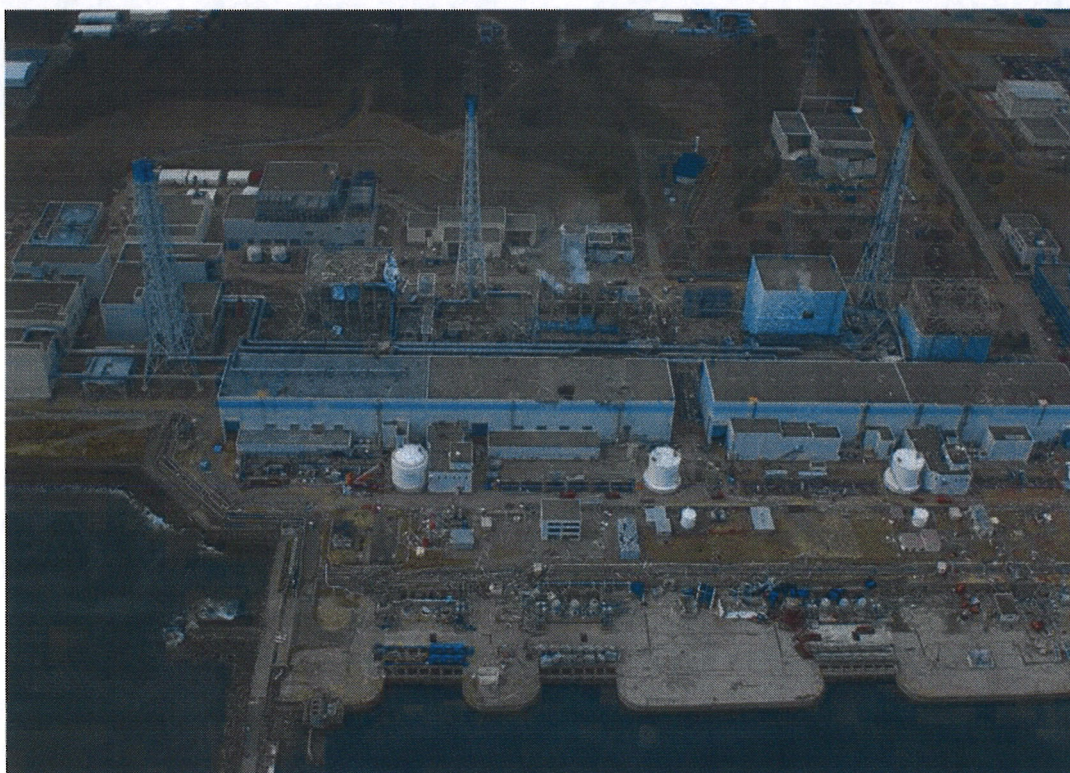
写真2.1.3-1 事故後の福島第一原発1～4号機（東側から） 45
