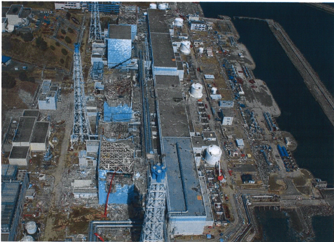
写真 2. 1. 3-2 事故後の福島第一原発1～4号機（南側から） 46
